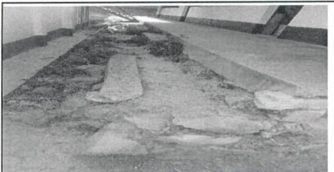
Foto 5: Área donde se realizará la Reparacion de muro de block
